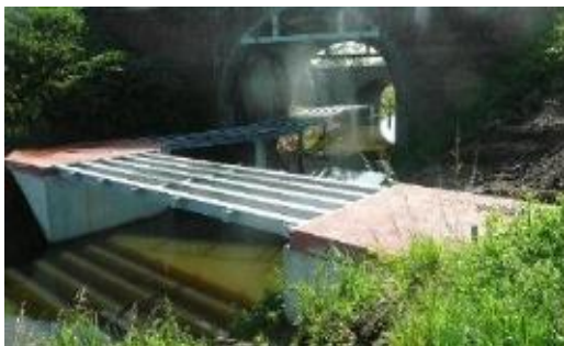
Foto tijdens de aanleg van deze fietsbrug.
