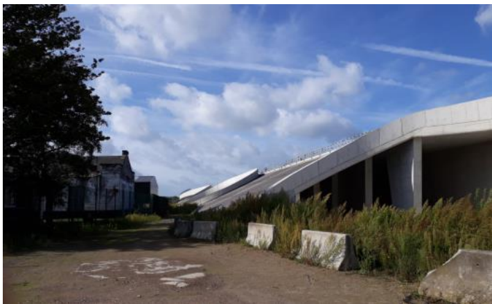
Zone voor fietsostrade met links de werkplaats en rechts een toekomstige groene zijwand voor de tunnel.
